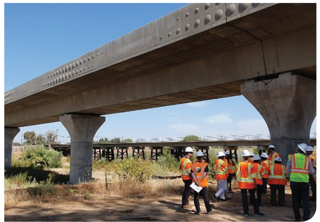
Ilustración 3 - Los pasos superiores e inferiores pueden adaptarse (A) para facilitar su uso por parte de la fauna y constituyen bandas de vegetación y barreras que reducen los trastornos acústicos y visuales del tráfico que circula bajo la estructura. El trabajo conjunto de ingenieros, ecólogos y paisajistas es crucial para garantizar la eficacia
